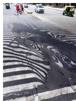
インド、熱波で道路が変形 出典：EPA 時事
